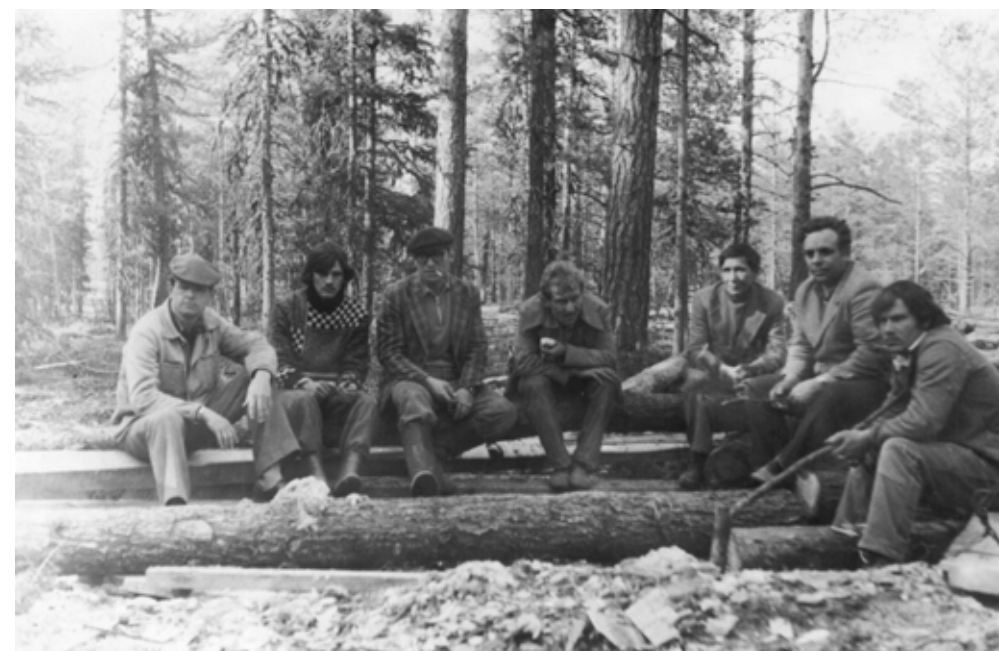
Валка леса под строительство дома. Бригада плотников Ливицкого. Май 1982 года
