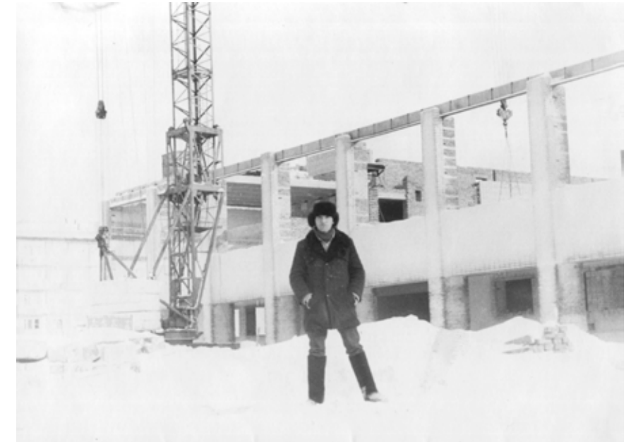
Г.П. Микаелян на строительстве школы № 3. Зима 1984
