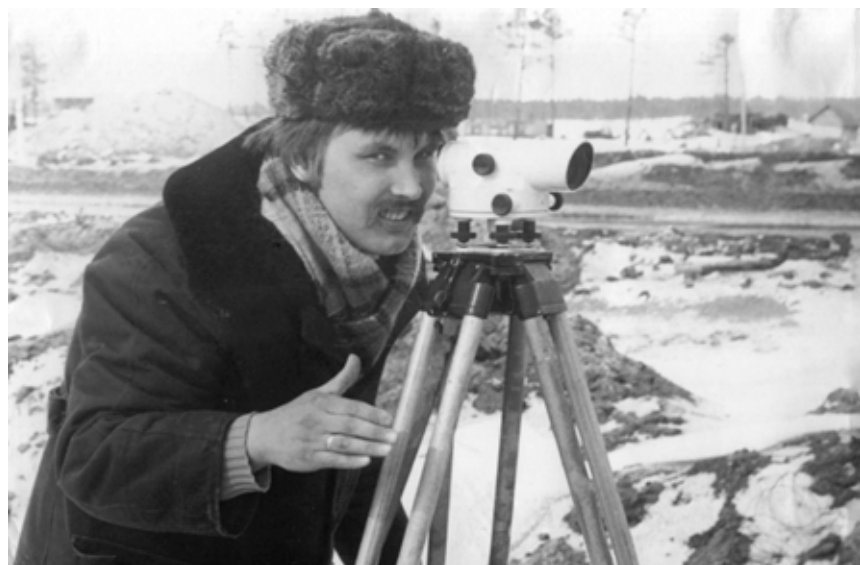
А. Х. Григорьев на разметке площадки под строительство здания ГУС. Радужный, 1985 год
