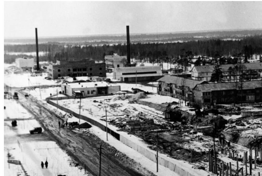
Первые котельные № 159, 160, обеспечивающие до постройки ИМПАК и КГВМ I очередь строительства. 1984
