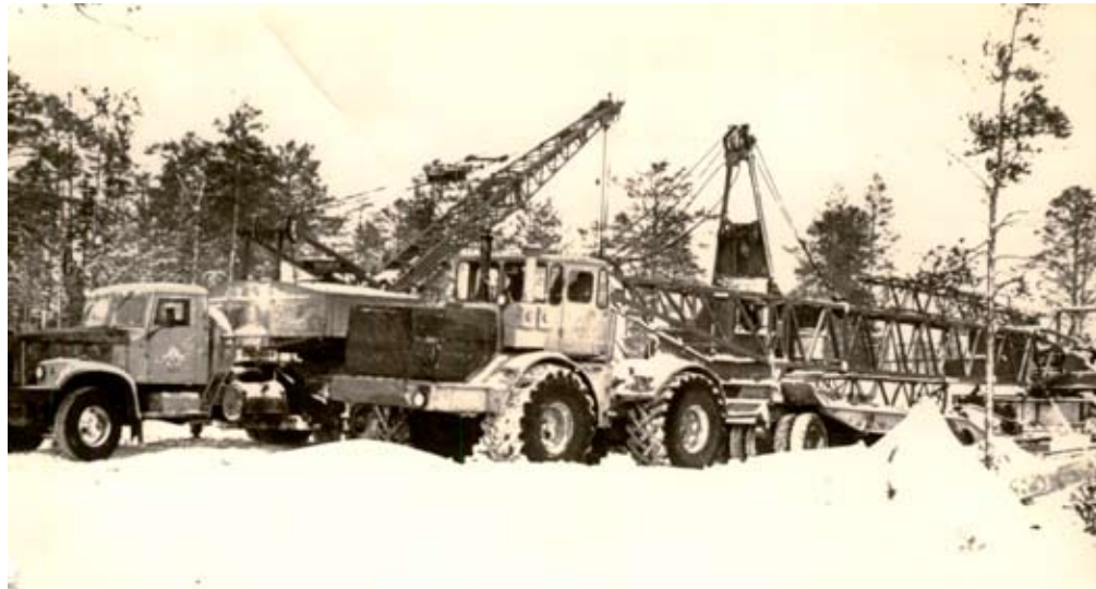
Переброска башенных кранов на строительство Радужного.
