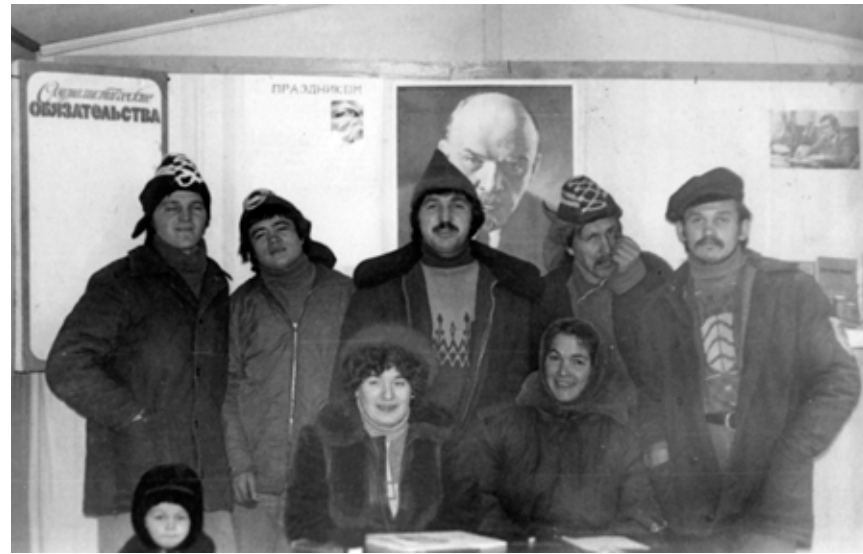
Первая бригада электромонтажников НМУ треста «Сибэлектромонтаж» на строительстве дома № 9 в 1-м микрорайоне. 1983
