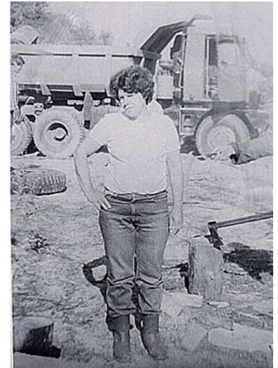
На строительстве моста через Амнуту. 1987 год
