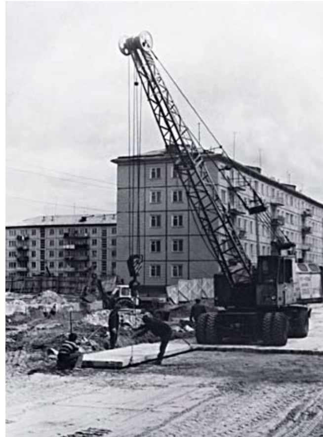
Укладка дорожных плит в 1-м микрорайоне
