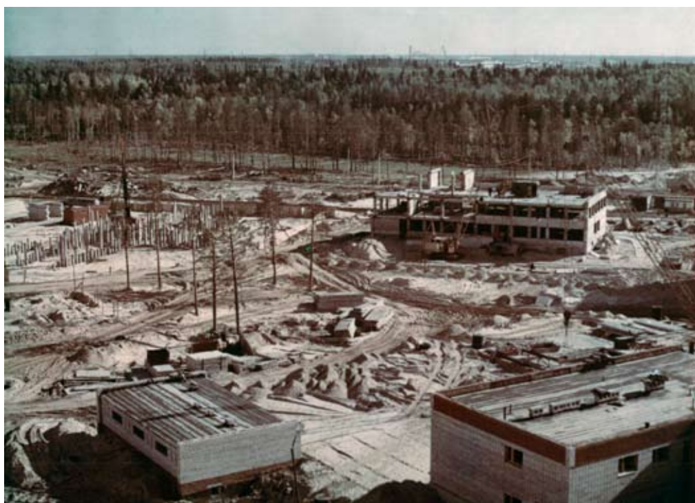
Вид сверху на стройку 7-го микрорайона. На переднем плане детский сад № 18 (СМУ «МНС», на заднем плане строящееся здание кафе-столовой «Лидия» (ныне «ГДДТ»))
