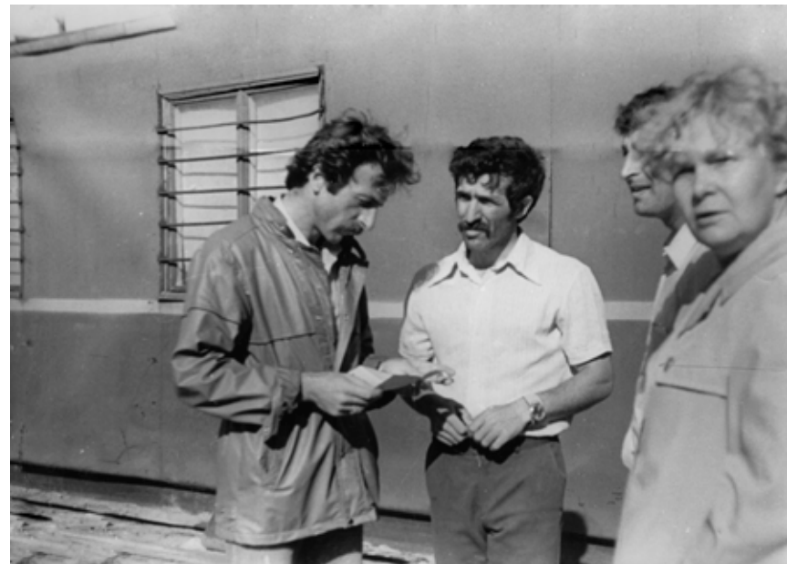
На участке СМУ-2, у вагон-городка. Начальник участка А.Г. Есян, Бригадир Каербек, начальник отдела техники безопасности Н.Д. Борзунова. 1982
