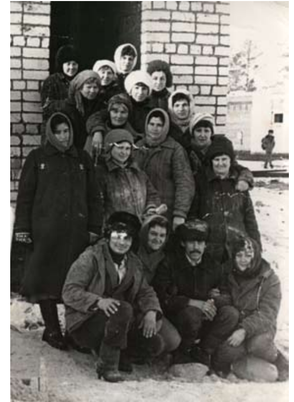
Бригада штукатуров-маляров СМУ-2 на строительстве школы № 2.
