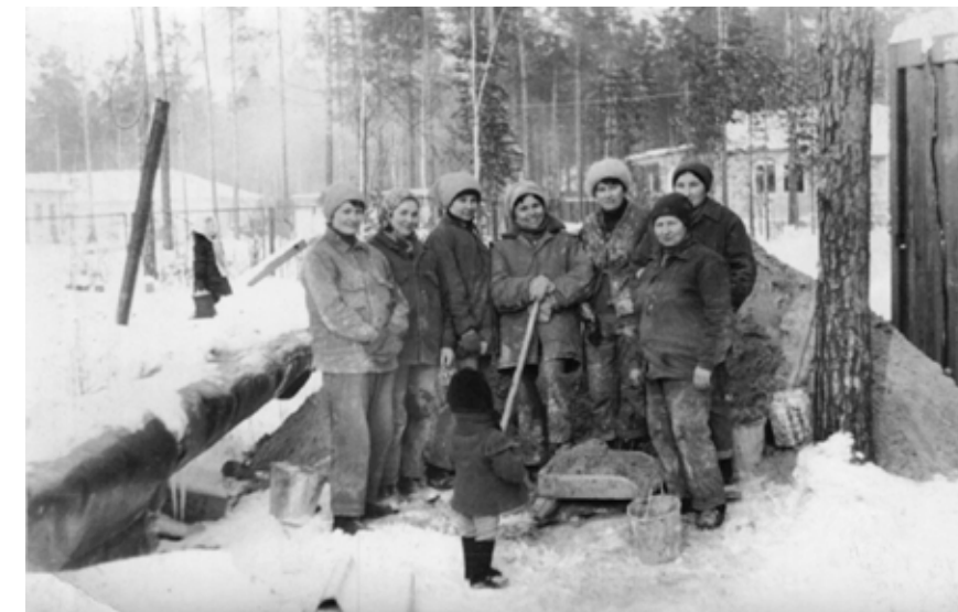
На строительстве гостиницы НГДУ «ВН». 1983
