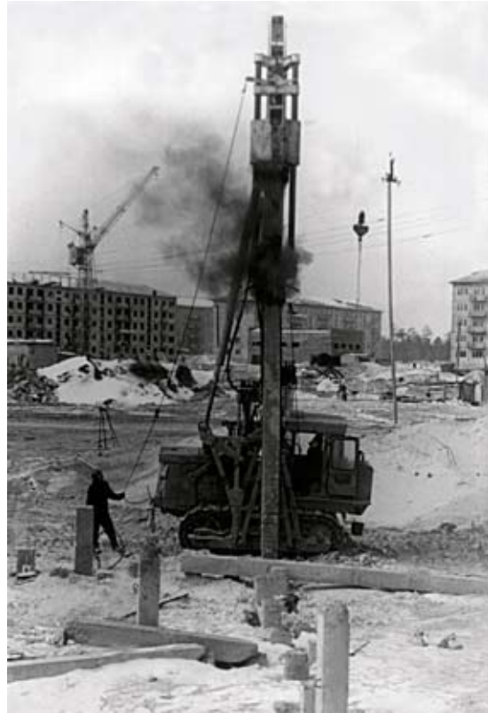
Забивка сваи. 3-й микрорайон. 1984
