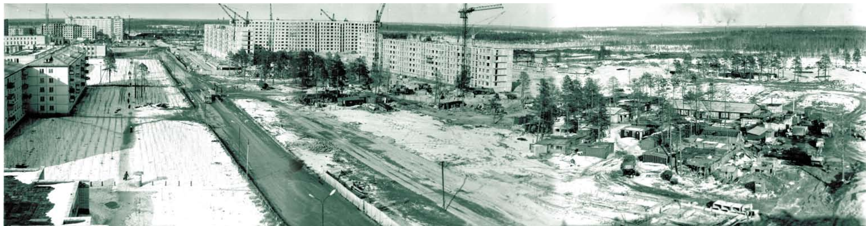
Панорама 1-го и строящегося 7-го микрорайонов. Вид со стороны 3-го микрорайона. 1987
