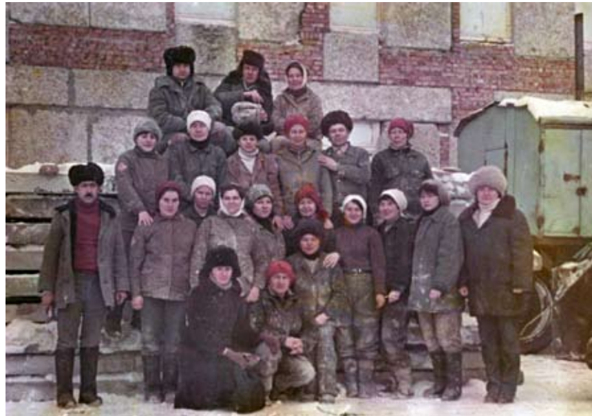
Бригада К.И. Паламарчук на строительстве горисполкома. 1987/88
