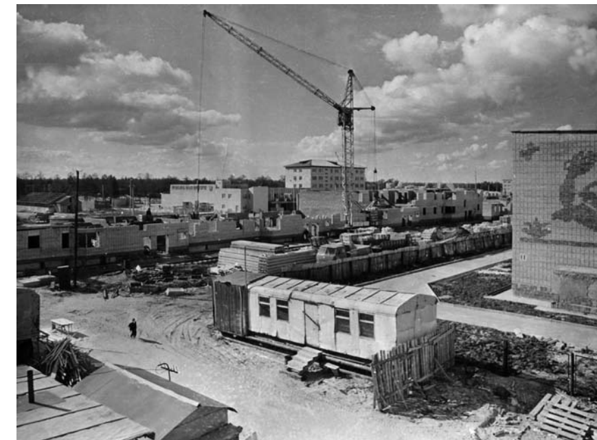
Строительство дома № 6а (строительный № 201) 1-го микрорайона
