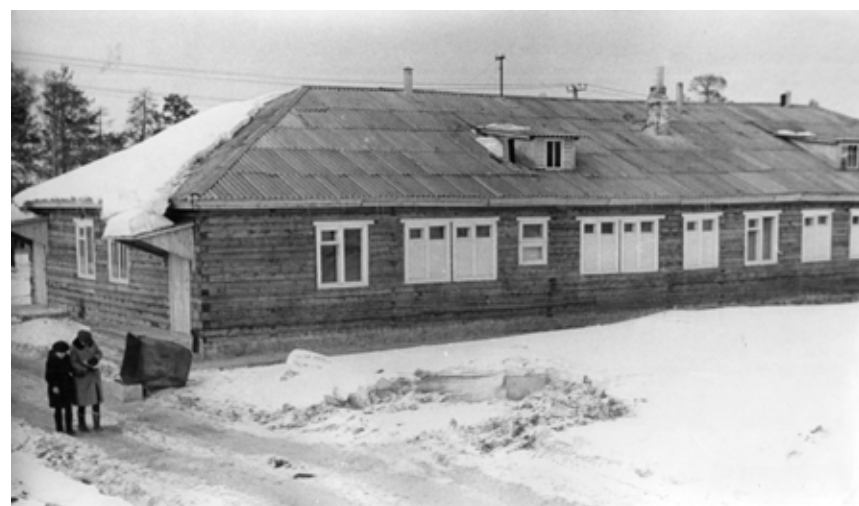
Баня на 40 моечных мест во 2-м микрорайоне. Первый объект, построенный А.Г. Есяном в Радужном. 1982
