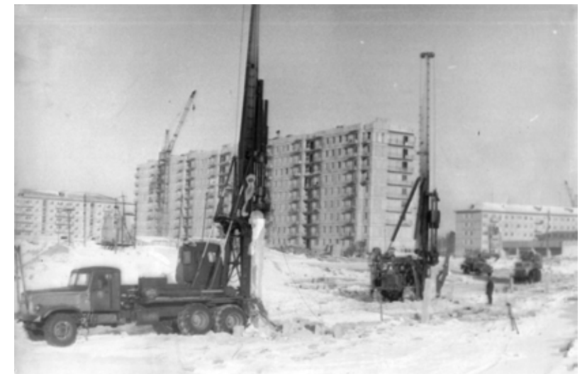
Забивка сваи для дома № 1 (115 стр.) 3-го микрорайона. 1984
