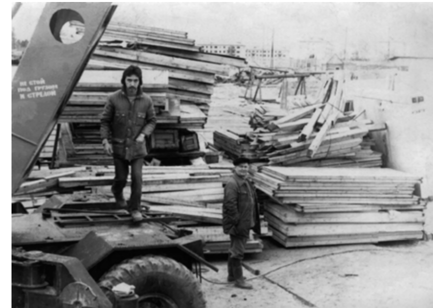
Накопитель строительных материалов
