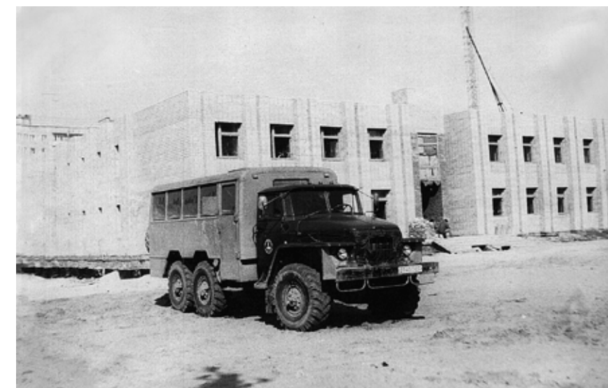
Строящийся Городской узел связи. 1986
