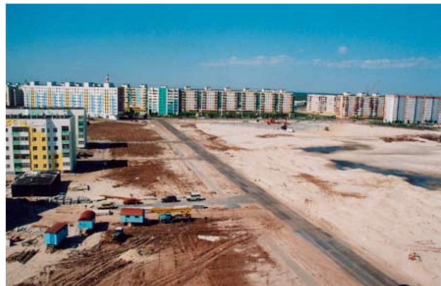
Отсыпка пустыря между 5-м и 6-м микрорайонами под Парк отдыха. 1999
