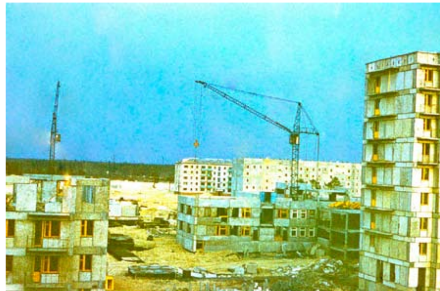
Вид на 6 микрорайон. Строится дом № 19, детский сад (ныне после реконструкции «Рябинка»).
