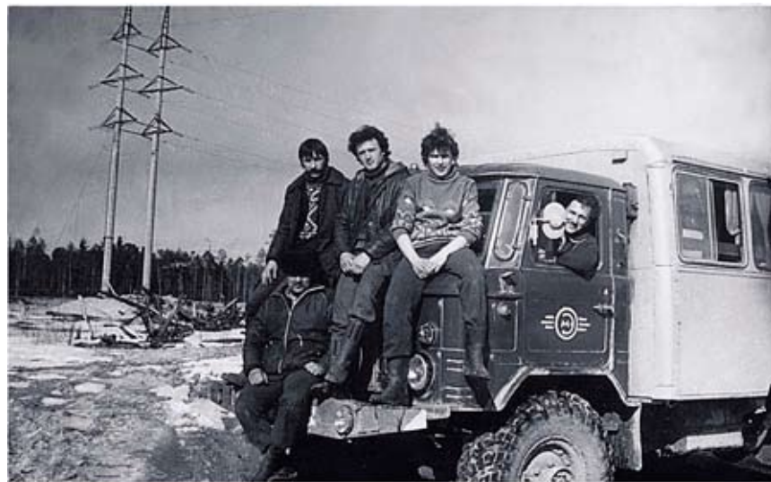
Выезд на строительство аэропорта
