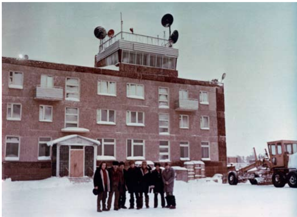
Работники «ПСС» на строительстве Аэропорта. 1987. Из архива Н.И. Ермолаевой
