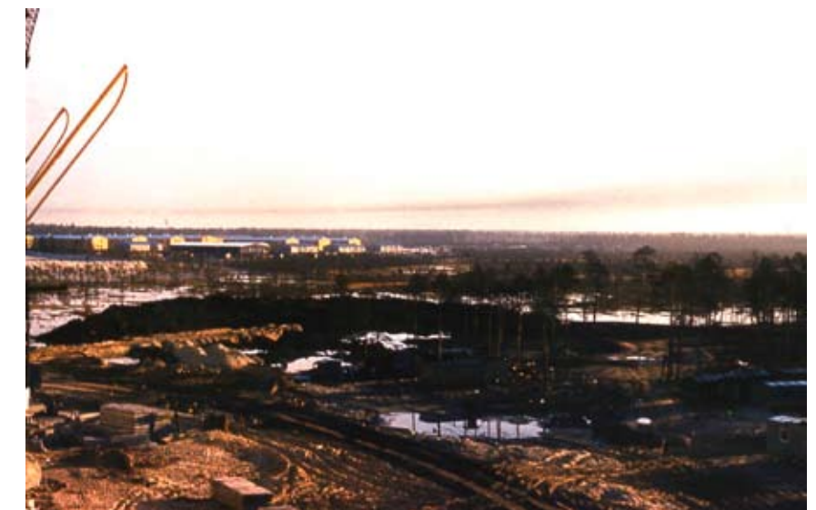
Вид на 9-й микрорайон. Готовится площадка для строительства дома № 20 в 6-м микрорайоне
