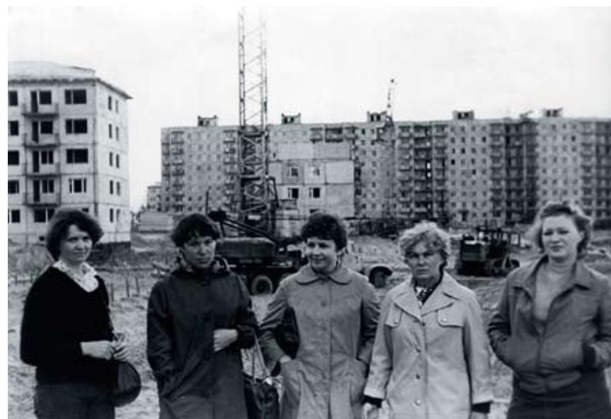
На стройке 1, 3-го микрорайонов. Работники СМТ-2. В центре З.Н. Храмова – инженер ТБ СМУ-1
