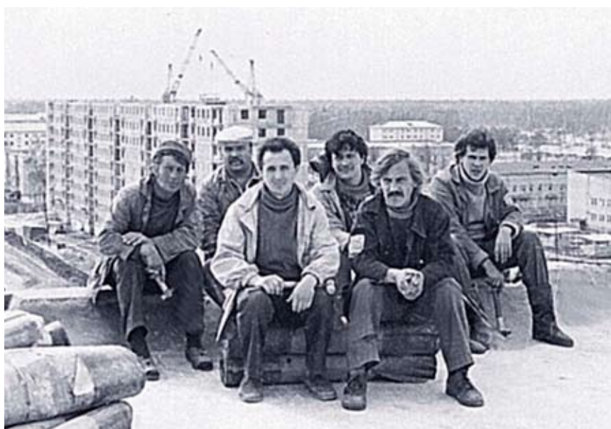
Электромонтажники на обеденном перерыве. Дом № 1 (35 стр.) 2-го микрорайона
