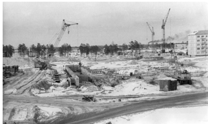
Фундаменты школы № 3. Слева краны на строительстве будущего клуба «Строитель». 1984
