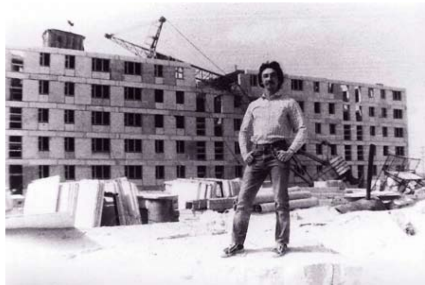
Р.Д. Мамуров на фоне упавшего на дом подъемного крана. 1989
